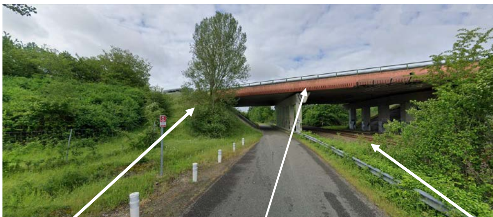
Talus de l'A20
